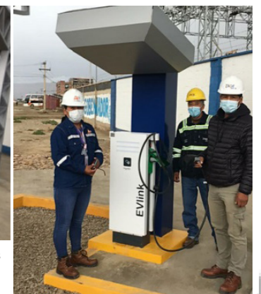
"Subestación Norte" de ENDE DEORURO, entre calles Campo Jordán y Tacna de la ciudad de Oruro
